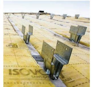
La solution pour une rénovation haute performance grâce au **pilier Intégra Réno**. Jusqu'à 3 couches d'isolant superposées, en limitant les ponts thermiques pour atteindre une performance thermique R au delà de 8 m<sup>2</sup>.K/W.
