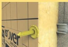
Mise en place de la rondelle rigide en laissant dépasser l'appui de 3 cm. Bloquer la rondelle par rotation quart de tour.
