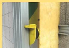
Mise en place de la fourrure verticale calée en parties basse et haute dans les lisses clip Optima (non représentées) et clipsage de la fourrure sur la clef d'appui.
