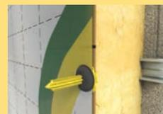
Application de la rondelle élastique de façon étanche par pincement de la membrane Vario®. L'étanchéité à l'air est désormais assurée.
