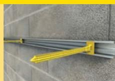
Mise en place par clipsage des appuis Optima<sub>2</sub>.
