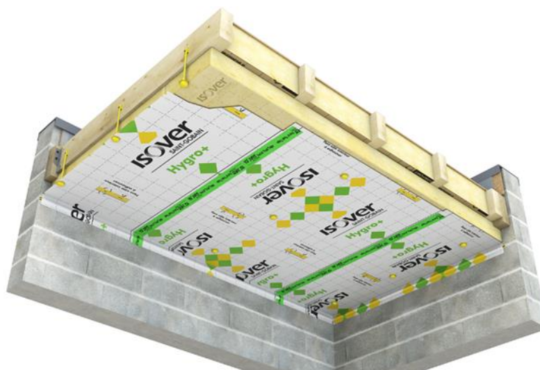
Figure 10 : Pose de la membrane Hygro+, clipsage au maillet des clés des suspentes Intégra 2 , jonction des lés à l'adhésif VARIO® FAST TAPE, jointoiement en périphérie au mastic VARIO® DOUBLE FIT.
