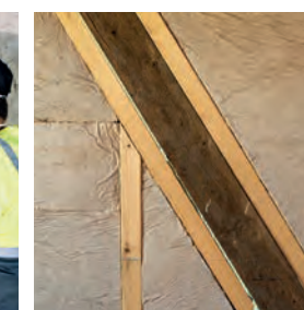
Combles aménagés entre chevrons ou sous-chevrons
