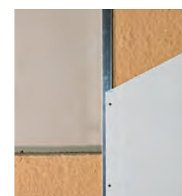
Murs par l'intérieur sous ossature secondaire métallique
