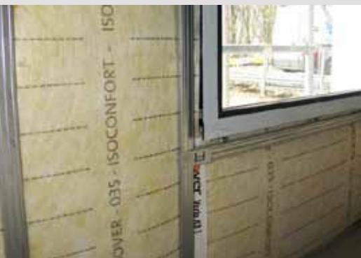
Pose système / Intérieur 8 / pose des écarteurs
