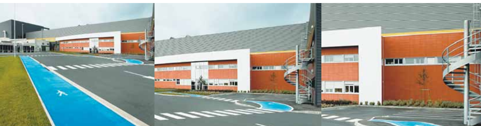
Façade F4 - Bureaux de l'usine de Chemillé - Saint-Gobain Isover
