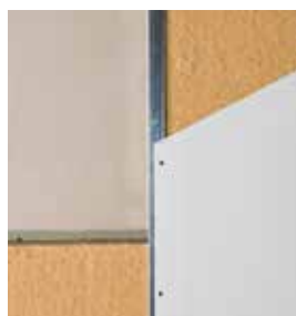
Murs par l'intérieur sous ossature secondaire métallique
