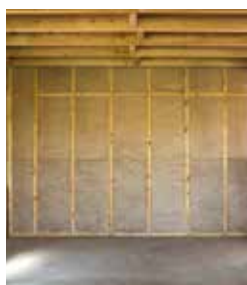
Murs par l'intérieur à ossature bois
