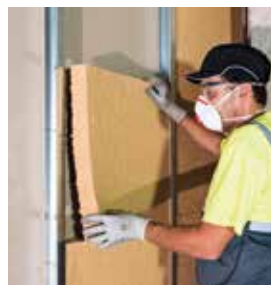
Cloisons séparatives et distributives
