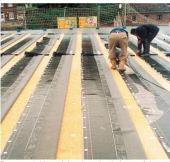
Panneau rigide en laine de roche de haute résistance mécanique. Revêtu d'un voile de verre pour les épaisseurs jusqu'à 95 mm.
