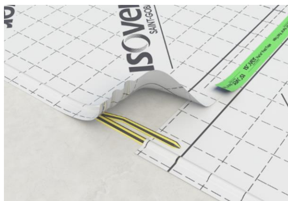
Figure 8 : Précautions à prendre lors de la pose du mastic VARIO® DOUBLE FIT ou DOUBLE FIT+
