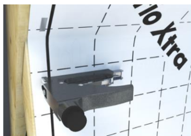
Agrafer la membrane sous les fermettes
