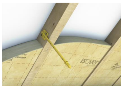
Visser la tige sur le flanc du chevron
