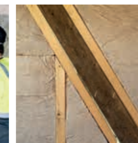
Combles aménagés entre chevrons ou sous-chevrons
