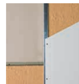
Murs par l'intérieur sous ossature secondaire métallique
