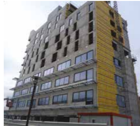
Bâtiments tertiaires et logements Imbrika - Nantes - Architectes Brenac et Gonzales.
