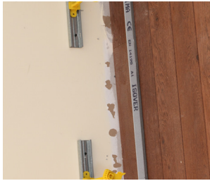
4 PLACEMENT DE LA LISSE BASSE
