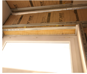
8 VUE DE L'OSSATURE DE TABLEAU
