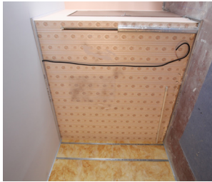
2 POSE DES LISSES CLIP-OPTIMA
