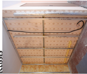
6 OSSATURE AVANT PROLONGEMENT DES ÉCLISSES
