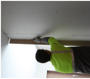
4 DÉCOUPE PAREMENT SUR L'ANGLE
