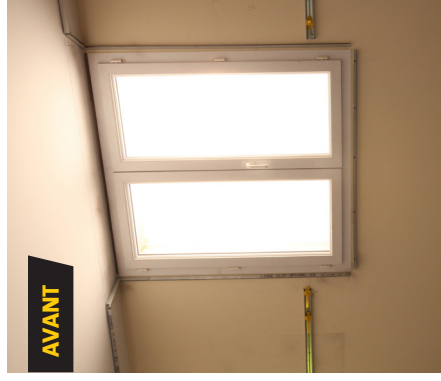
Ossature murale, lisse Clip'Optima en entourage de fenêtre et fourrure horizontale.
