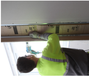
3 VISSAGE LISSE D'ANGLE
