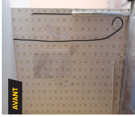
État existant et passage de gaines électriques ou plomberie
