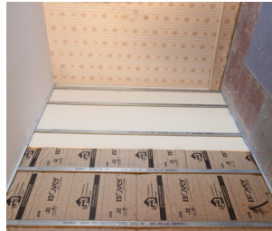
5 POSE D'UNE FOURRURE D'ANGLE
