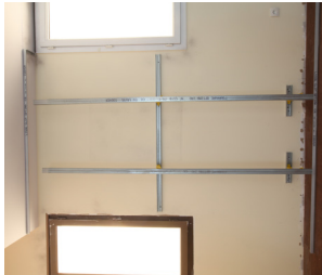
7 PLAN DE L'OSSATURE (VUE SANS ISOLANT)
