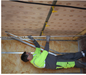
4 POSE DES FOURRURES VERTICALES
