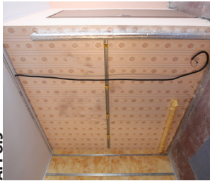
3 POSE DES FOURRURES HORIZONTALES ET APPUIS
