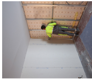
6 POSE D'UNE LISSE D'ANGLE
