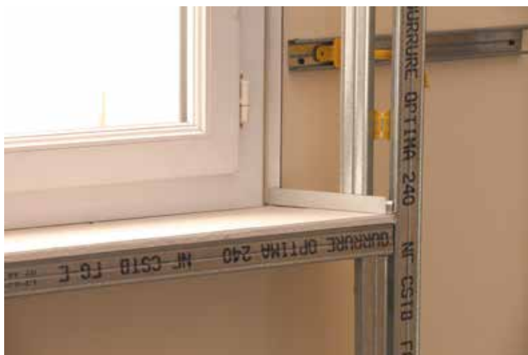
Exemple : pose d'ossature en périphérie de menuiserie
