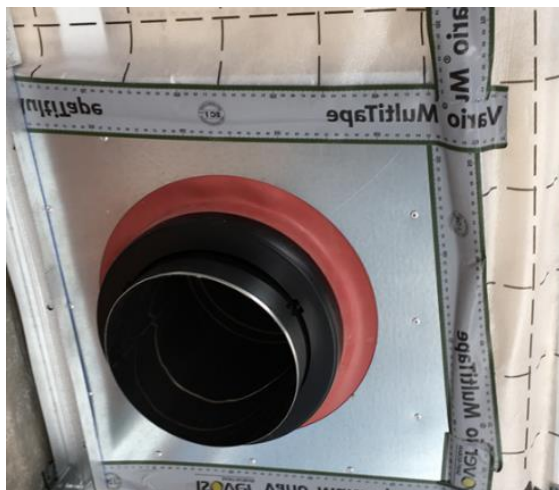
Figure 22 : Détail de la jonction entre la membrane Hygro+ et la plaque de distance de sécurité étanche (parfois appelée plaque d'étanchéité), soit grâce à l'adhésif VARIO® MULTITAPE ou VARIO® FAST TAPE, soit grâce à l'adhésif éventuellement incorporé à la plaque d'étanchéité, après vérification de sa compatibilité avec la membrane Hygro+.
