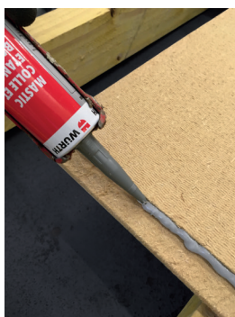
Joint mastic adapté (voir p19) appliqué dans le creux de la languette
