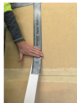
Bande adhésive appliquée sur le joint après application d'un primaire liquide ou en spray (voir p19)
