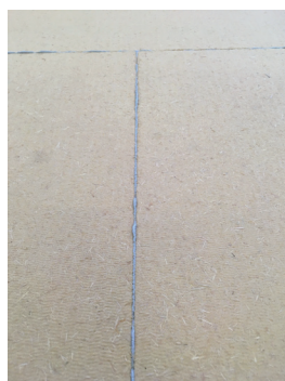
Joint mastic adapté (voir p19) appliqué dans le creux de la languette
