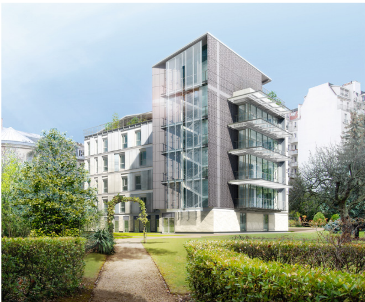
© ALC - Chantier EHPAD Soeurs Sainte Augustines - Paris XIIIè
