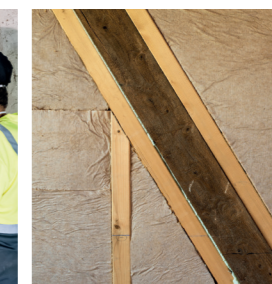
Combles aménagés entre chevrons ou sous-chevrons
