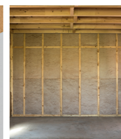
Murs par l'intérieur à ossature bois
