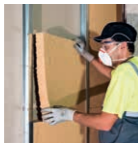
Cloisons séparatives et distributives
