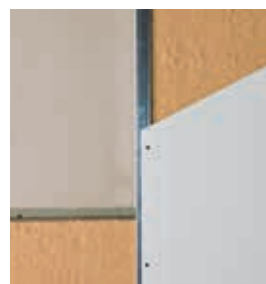
Murs par l'intérieur sous ossature secondaire métallique
