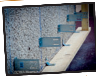
En partie basse, à 20 cm au-dessus du sol, une planche traitée insecticide, fongicide et hydrofuge est fixée avec des querres pour protéger le bas des isolants contre les rejaillissements d'eau.
