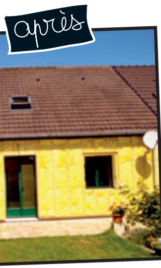
Une deuxième couche d'isolant de 32 mm est insérée entre les montants de l'ossature bois. Un cran pare-pluie est ensuite agrafé ou cloué sur l'ossature bois.
