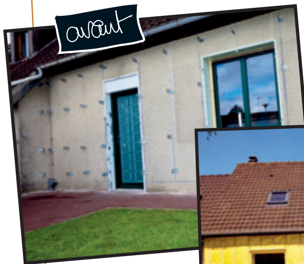
Des querres qui supporteront l'ossature du bardage sont fixées avec un entraxe de 60 cm en largeur et de 135 cm en hauteur avec des fixations adaptées au support.
