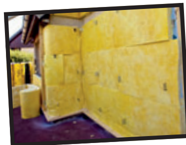
Une première couche d'isolant de 32 mm est insérée et embrochée horizontalement sur les querres. Une pose verticale est également possible. Mais elle oblige de nombreuses coupes si la hauteur du bâtiment est faible.
