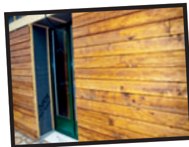
Les lames de bardage sont clouées avec des pointes anneaux ou crantées au droit des montants de l'ossature bois.
