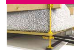
Isolation à souffler
